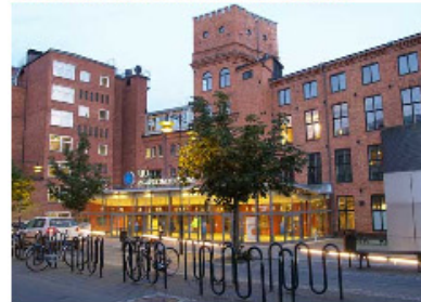
Kåkenhus (entrén från Bredgatan)
