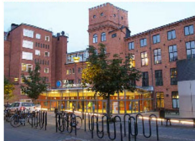
Kåkenhus (entrén från Bredgatan)
